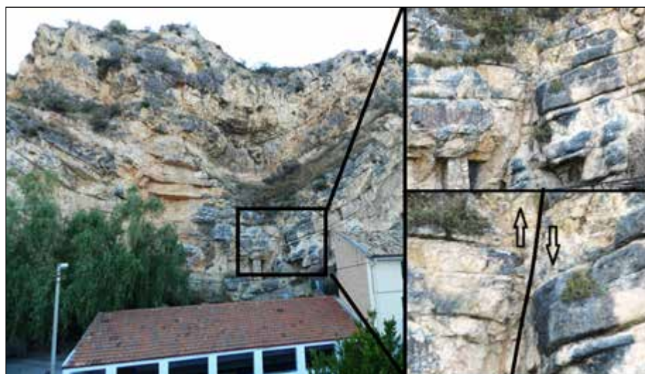
Fig. 9. Pequeña falla asociada a un pliegue sinclinal afectando a calizas del Cretácico superior detrás del lavadero municipal.
